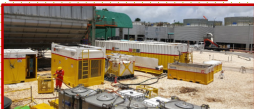
Chemical Cleaning-HRSG
